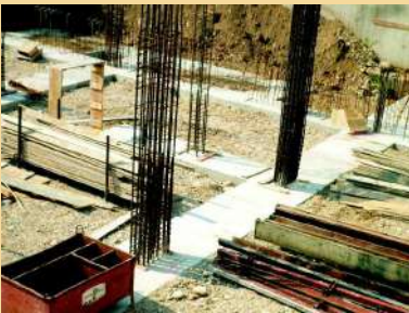
Fondazione continua , in primo piano le chiamate in ferro per il successivo getto dei pilastri di elevazione.
