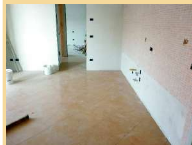
Pavimentazione in GRES , fase di posa dei pavimenti della zona soggiorno.
