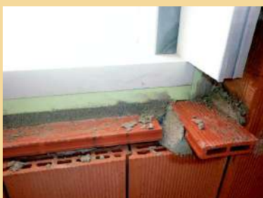
Bancale finestra in Pietra "Trani", dettaglio del nodo bancale controcaassa del serramento con profilo metallico e termocoibentato per eliminare i ponti termici. il contro-bancale è coibentato ai lati e sulla pancia con pannello di Polistirene.
