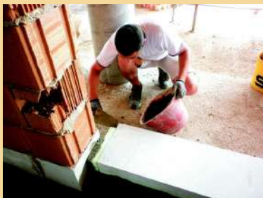
Soglia portafinestra in Pietra "Trani", dettaglio della posa in prossimità dell'attacco al muro perimetrale, da notare lo strato di polistirene per impedire ponti termici.
