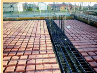
Solaio del primo piano fuori terra dettaglio di posa dei travetti armati per il successivo getto di calcestruzzo, in primo piano l'armatura delle travi in c.a. per il sostegno dell'intera struttura.
