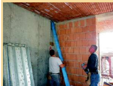
Colonne di scarico , fase di posa intrasoia di una tubazione silenziosa.
