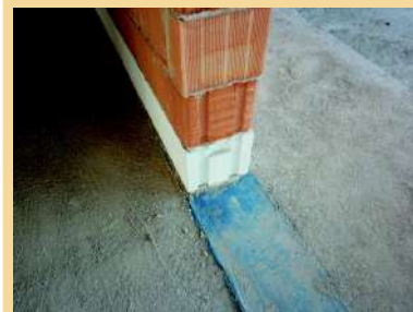
Guaina impermeabilizzante , posata a contatto con il solaio del piano terra per evitare la risalita dell'umidità.
