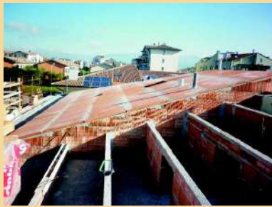
Struttura di copertura , dettaglio della fase di posa dei muretti in laterizio e dei soprastanti tavelloni.
