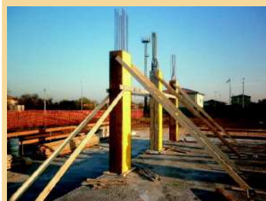
Pilastri in cemento armato , dettaglio della fase di armatura per il successivo getto in C.A.
