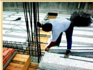
Lastre "Predalles" fase di armatura del solaio al piano terra, questi tipi di solai a copertura dei piani interrati, possono presentare nei primi due anni di esercizio delle piccole infiltrazioni di acqua accumulata durante le fasi di cantiere all'interno delle lastre e comunque destinata ad evaporare o scendere nei periodi di bassa pressione atmosferica, pertanto è importante non forare per qualsiasi motivo i soffitti dei garage.
