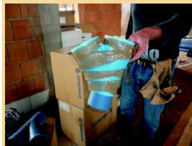
Colonne di scarico , dettaglio di un raccordo silenzioso "Polokal NG" di POLIPALST avvolto nella guaina "FONoDBAM" di BAMPI antivibrazione in polietilene.
