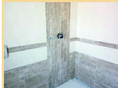
Dettagli del rivestimento di un bagno.
