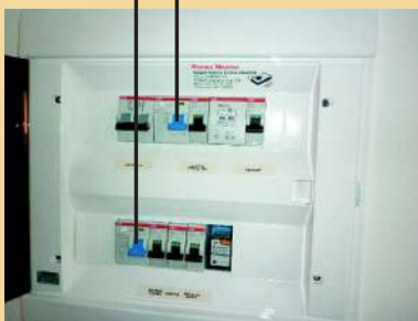
Diff. magnetotermico generale alloggio 2x25 0,03
