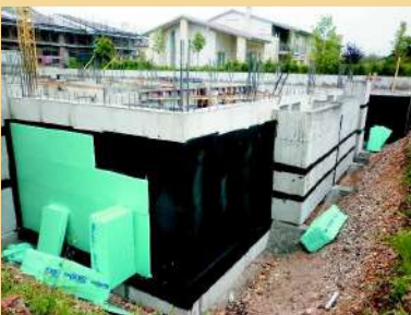
Murature di elevazione , murature perimetrali in C.A. con le opere di impermeabilizzazione e coibentazione.
