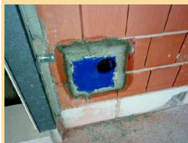
FONOPROTEX è rivestito all'interno di poliuretano espanso (a celle aperte su base poliestere) dotato di notevole flessibilità e incombustibile.
