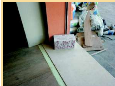
Dettaglio pavimentazione in GRES , da notare la fascia isolante per evitare il ponte termico tra il pavimento interno e la soglia esterna.
