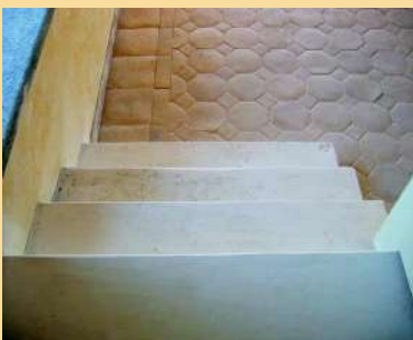
Pavimentazione scala interna, dettaglio della posa delle alzate e pedate in pietra di "Prun" spazzolata.
