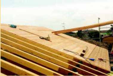
Struttura di copertura , dettaglio della struttura lignea tipo di un tetto ventilato.
