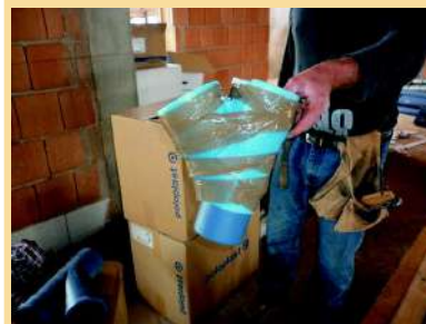
Colonne di scarico , dettaglio di un raccordo silenziato "Polokal NG" di POLIPALST avvolto nella guaina "FONdodBAM" di BAMPI antivibrazione in polietilene.
