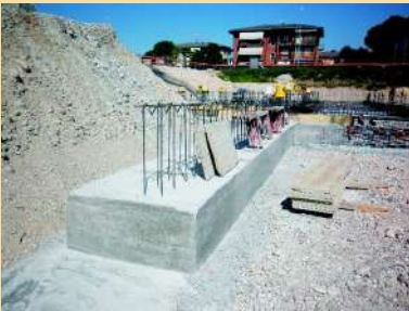
Fondazione continua , in primo piano le chiamate in ferro per le successive murature di elevazione.
