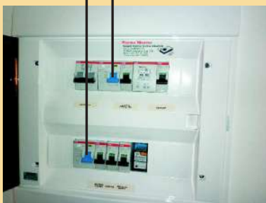
Diff. magnetotermico generale alloggio 2x25 0,03
