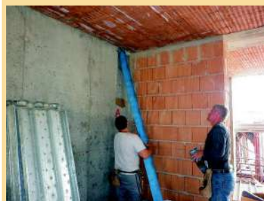
Colonne di scarico , fase di posa intrasolaio di una tubazione silenziata.
