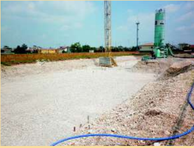
Area di scavo , fase preliminare per i successivi getti di fondazione
