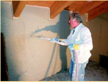
Parete interna. Fase di stesura meccanica del primo strato di intonaco.
