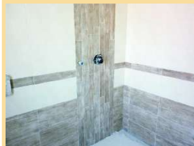
Dettagli del rivestimento di un bagno.
