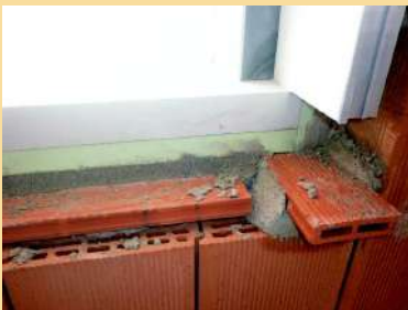
Bancale finestra in Pietra di "Prun", dettaglio del nodo bancale controcassa del serramento con profilo metallico e termocoibentato per eliminare i ponti termici. il controbancale è coibentato ai lati e sulla pancia con pannello di Polistirene.
