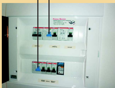
Diff. magnetotermico generale alloggio 2x25 0,03
