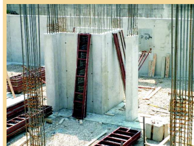
Murature di elevazione , dettaglio del vano ascensore in C.A. Gettato in opera.
