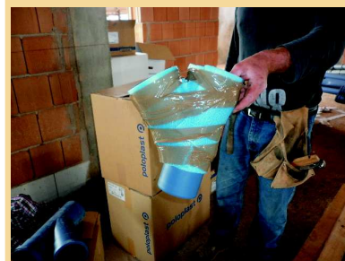
Colonne di scarico , dettaglio di un raccordo silenziato "Polokal NG" di POLIPALST avvolto nella guaina "FONOdBAM" di BAMPI antivibrazione in polietilene.
