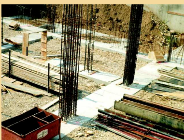
Fondazione continua , in primo piano le chiamate in ferro per il successivo getto dei pilastri di elevazione.
