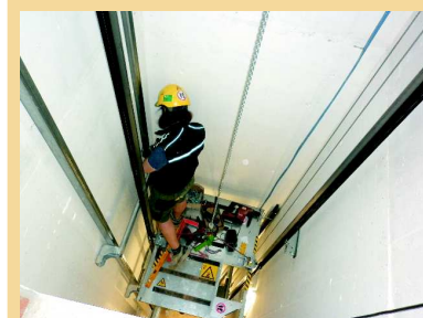
Ascensore , dettaglio della fase di posa.
