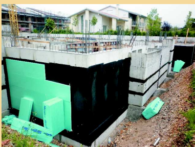
Murature di elevazione , murature perimetrali in C.A. con le opere di impermeabilizzazione e coibentazione.
