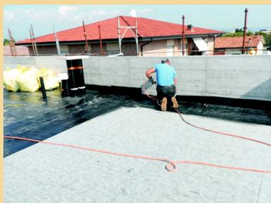
**Struttura di copertura**, dettaglio della fase di posa della guaina impermeabilizzante a chiusura del pacchetto di copertura.
