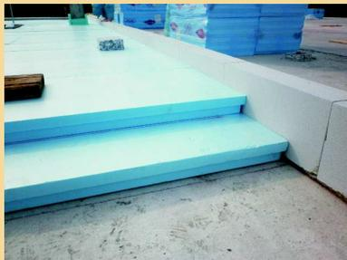
**Pacchetto di copertura**, dettaglio dei pannelli in XPS sp. 16 cm. L'elevato spessore della coibentazione termica e l'elevata massa termica della stessa permettono, inoltre, un'ottimizzazione del comfort durante la stagione estiva in quanto aumentano lo sfasamento termico (ritardo) tra il caldo incidente in copertura e quello entrante nelle abitazioni.
