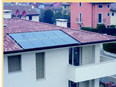
**Pannelli fotovoltaici**, dettaglio della posa sul fronte sud della copertura di un fabbricato.
