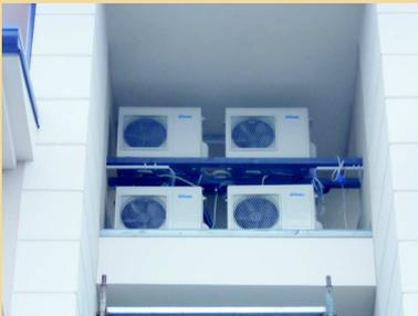
**Pompa di Calore.** Dettaglio della posa dei macchinari locati in apposito vano sulla copertura ben arieggiato.
