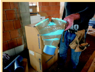
Colonne di scarico , dettaglio di un raccordo silenziato "Polokal NG" di POLIPALST avvolto nella guaina "FONOdBAM" di BAMPI antivibrazione in polietilene.
