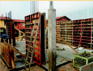
Murature di elevazione , fase di armatura per il successivo getto in opera.
