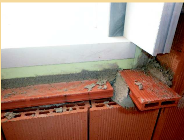
Bancale finestra in Pietra "Trani", dettaglio del nodo bancale controcassa del serramento con profilo metallico e termocoibentato per eliminare i ponti termici. il controbancale è coibentato ai lati e sulla pancia con pannello di Polistirene.
