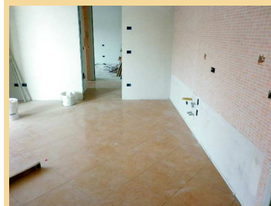
Pavimentazione in GRES , fase di posa dei pavimenti della zona soggiorno.
