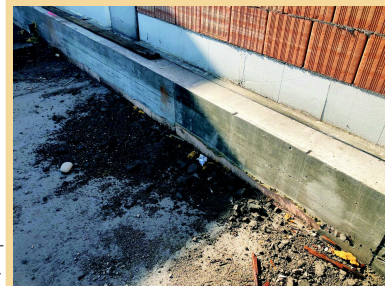
Solaio piano terra , dettaglio della platea con il sottostante pannello isolante.
