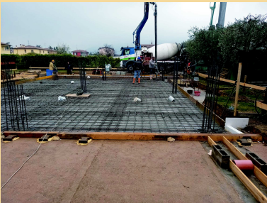
Platea di Fondazione , fase di getto del calcestruzzo a formazione della platea.
