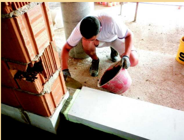
Soglia portafinestra in Pietra "Trani", dettaglio della posa in prossimità dell'attacco al muro perimetrale, da notare lo strato di polistirene per impedire ponti termici.
